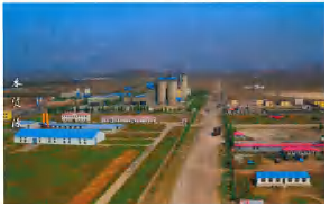
照片二 物流园区建筑
