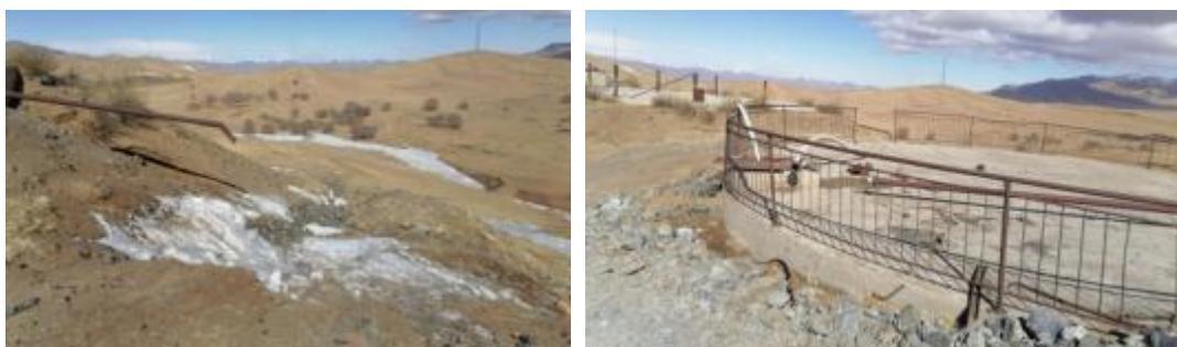
照片3-8 蓄水池及边缘堆积的渣石土
