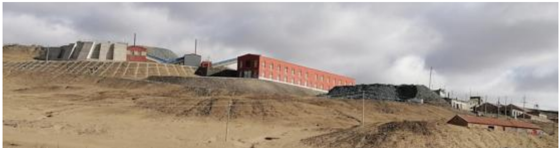
照片4-8 1#选矿厂护坡
