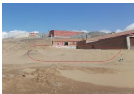
照片4-3 斜井XJ2废石场
