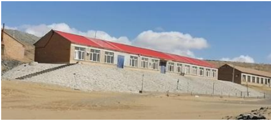
照片4-7 斜井XJ2工业场地护坡
