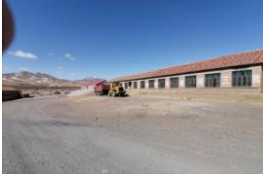
照片 3-2 斜井 XJ2 工业场地
