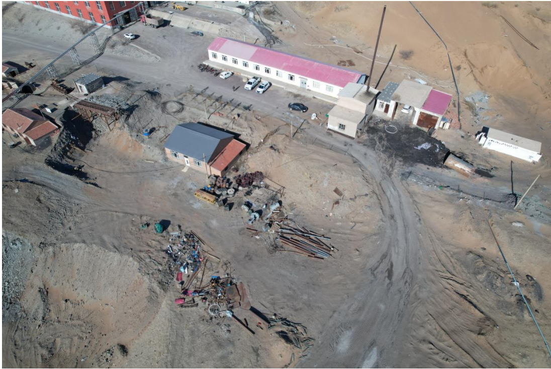
照片 3-1 斜井 XJ1 工业场地
