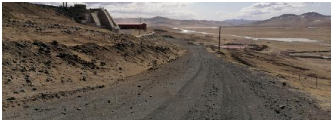
照片 3-12 矿区道路
