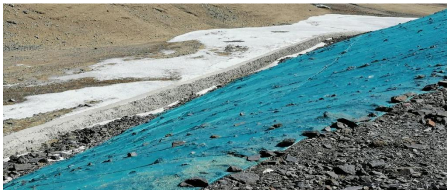
照片 3-7 XJ 废石场东侧边坡及挡墙
