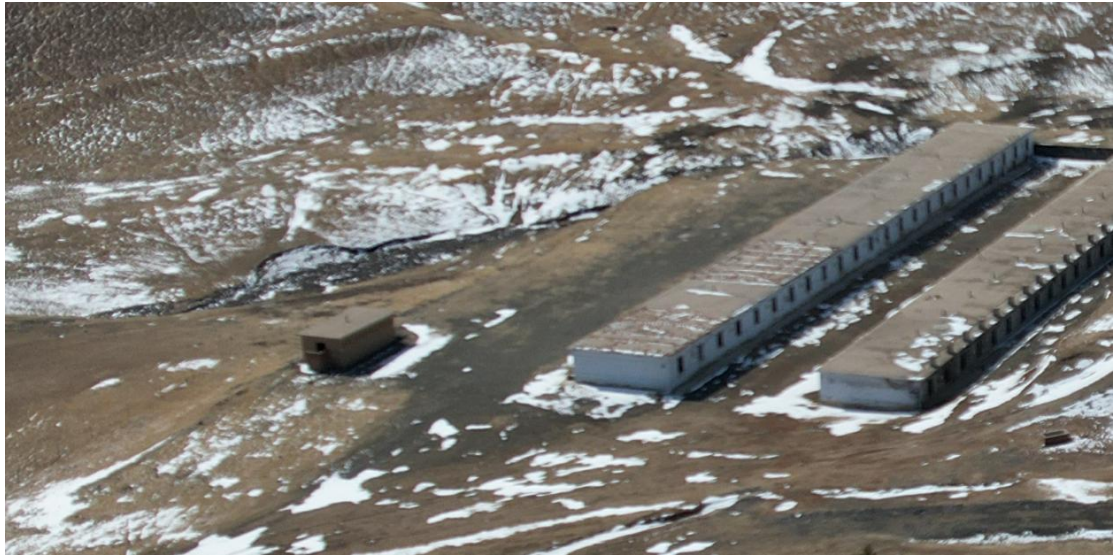
照片 3-14 宿舍 2 及南东侧堆坡
