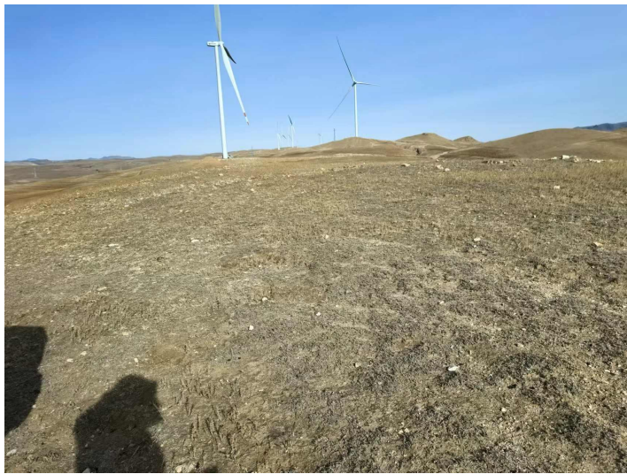
照片 3-6 临时安装平台
