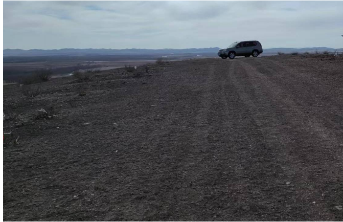
照片 3-5 临时施工道路
