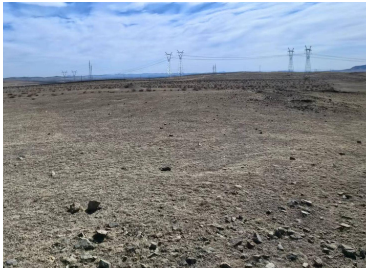
照片 3-7 临时安装基塔
