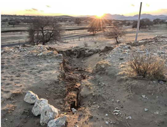
照片 3-6 办公生活区北侧堆坡
