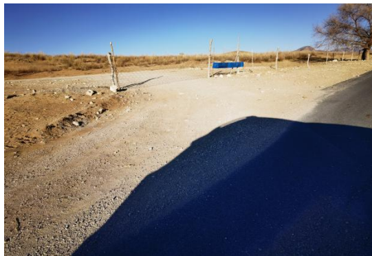
照片 3-7 矿区道路
