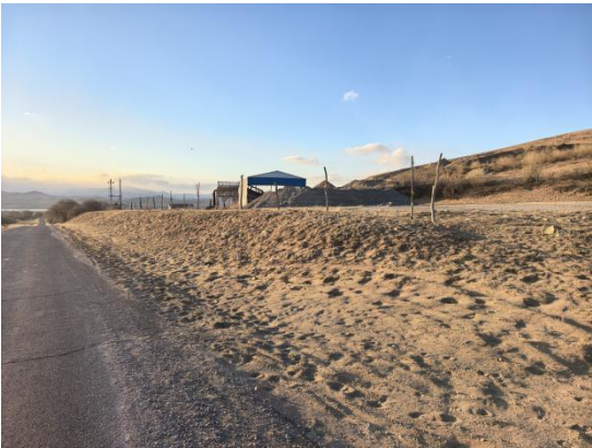
照片4-6 工业场地南侧堆坡治理效果
