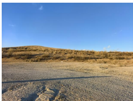
照片 4-3 工业场地北东侧边坡治理效果
