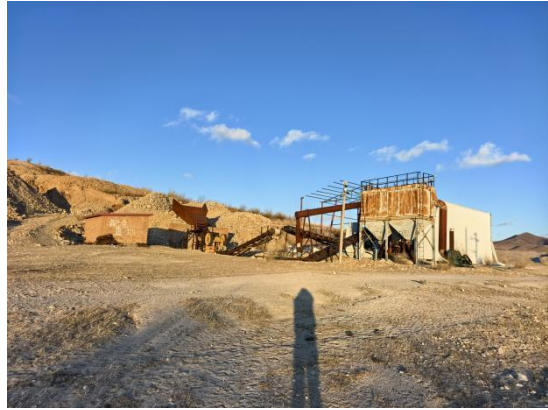
照片3-3 配电室及破碎设备
