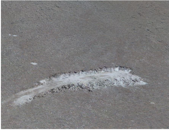
照片 6.1-1 钻机平台 1
