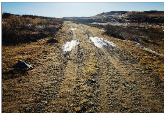
照片 3-8 矿区道路
