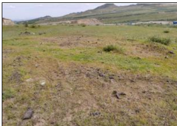
照片 4-2 探槽治理效果照片
