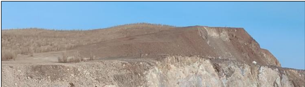
照片 4-3 探槽治理效果照片
