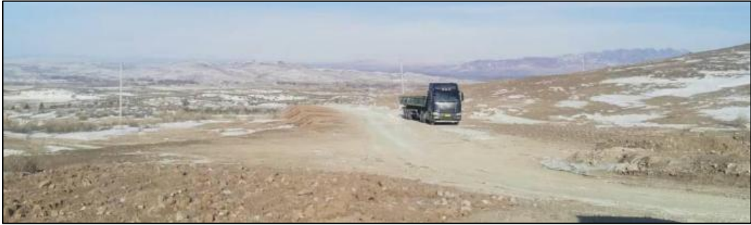
照片 4-4 矿区道路边坡治理效果
