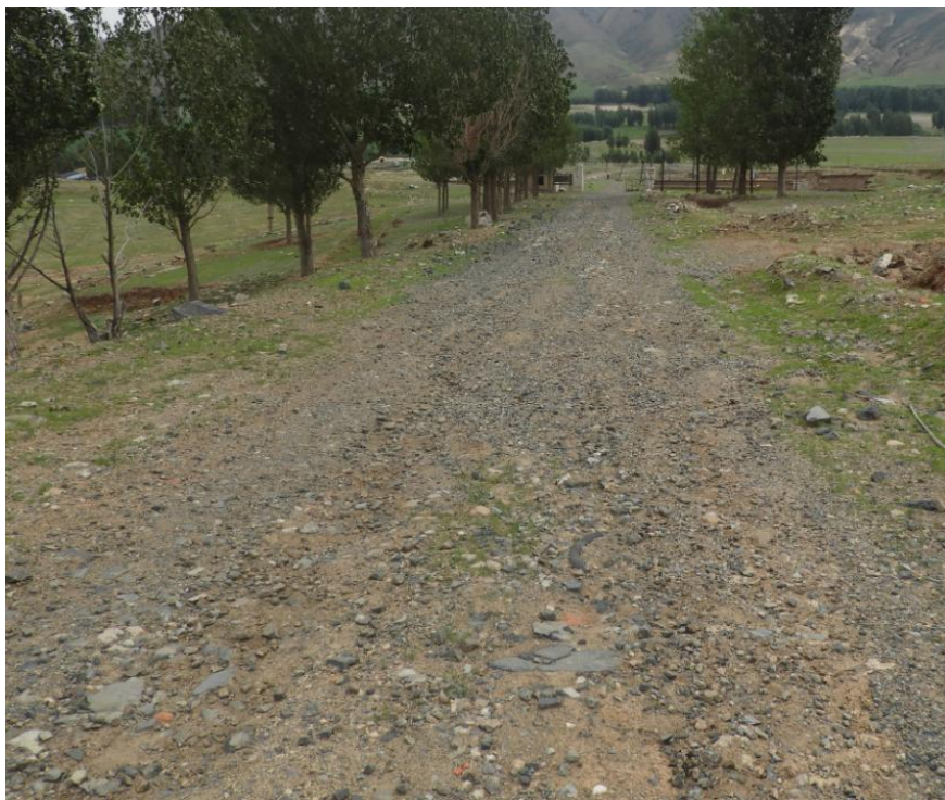
照片 3- 矿区道路
