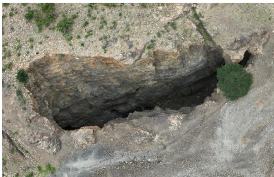
照片3-2 2号塌陷坑
