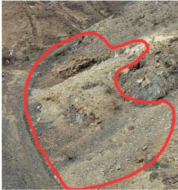
照片4-1 “挖损区”治理效果照片
