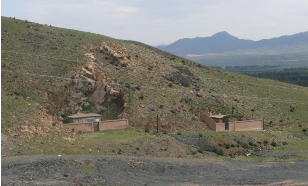
照片3-14 炸药库及雷管库
