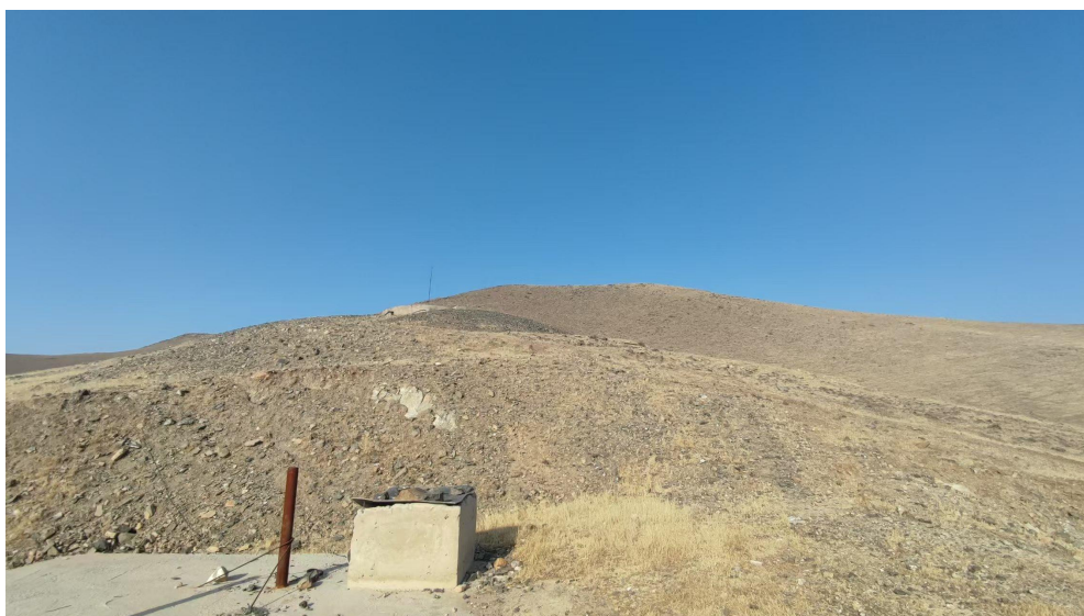
照片4-5 高位水池堆坡
