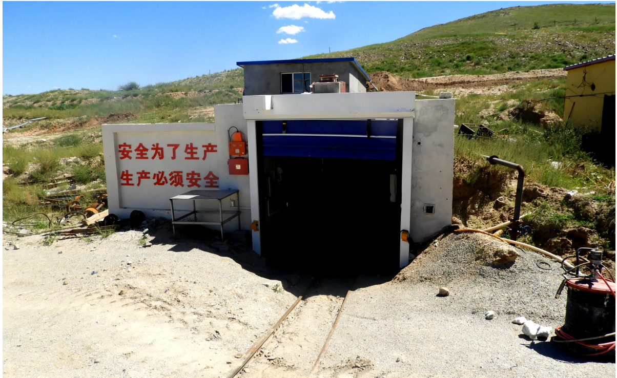
照片 3-2 斜井井口
