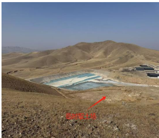
照片4-11 临时取土场
