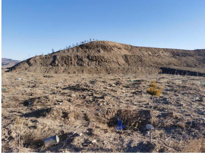
照片 2-13 露天采场北侧边坡及场地治理效果
