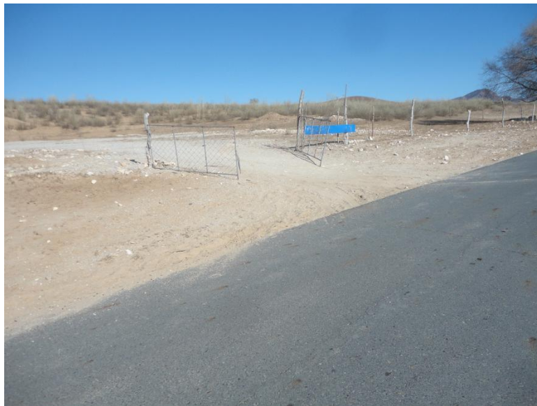
照片 3-18 矿区道路
